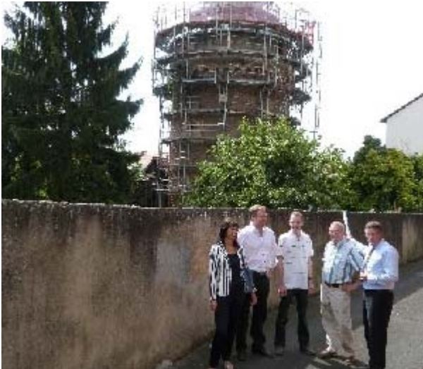
Ortstermin „Hexenturm“ in Gelnhäusen – Sanierungsarbeiten im Rahmen des Kommunalen Investitionsprogramms (KIP)
